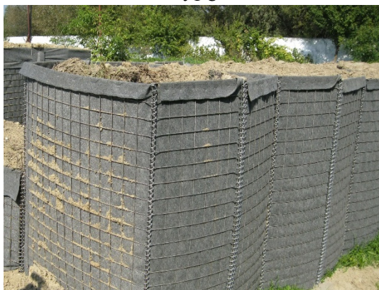
д) габіонні конструкції МГК-1 та МФСГ
